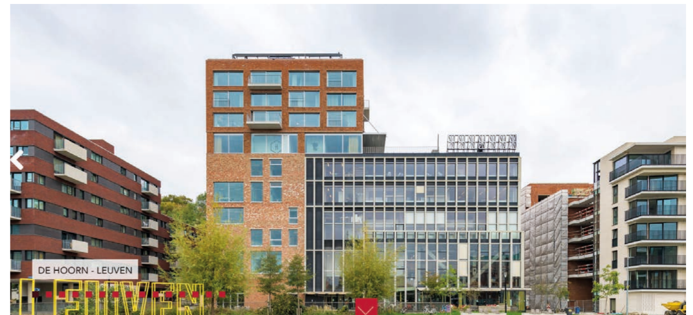
Miss Miyagi was als projectbegeleider eveneens betrokken bij de ontwikkeling van De Hoorn in Leuven en werkte mee het exploitatiemodel uit. Ook hier betreft het een gemengde herbestemming waarbij een exploitatievennootschap het gebouw uitbaat en de ruimtes aan de eindgebruikers ter beschikking stelt met inbegrip van alle diensten en beheer.
